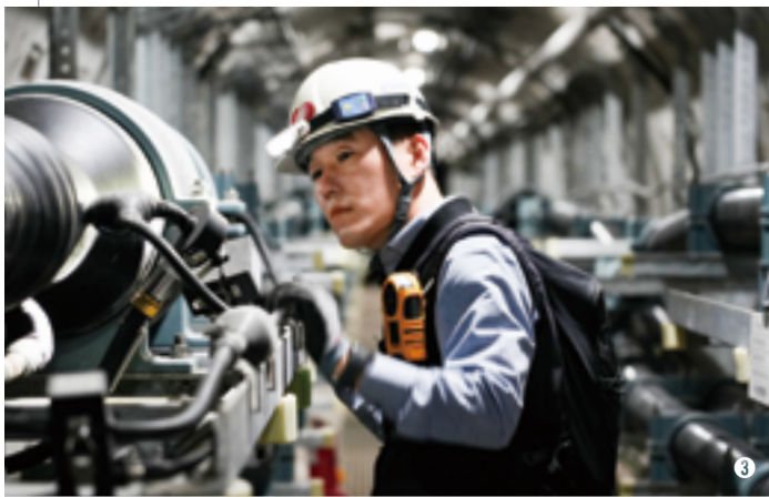
①, ③ 열화상 진단장비를 활용해 접속함 이상 유무를 면밀하게 살피는 순천전력지사 송전부 사수들. ②, ④ 해저터널 내 작업 시 안전을 위해 지상감시자와 PS-LTE 단말기로 통신하는 작업자.
