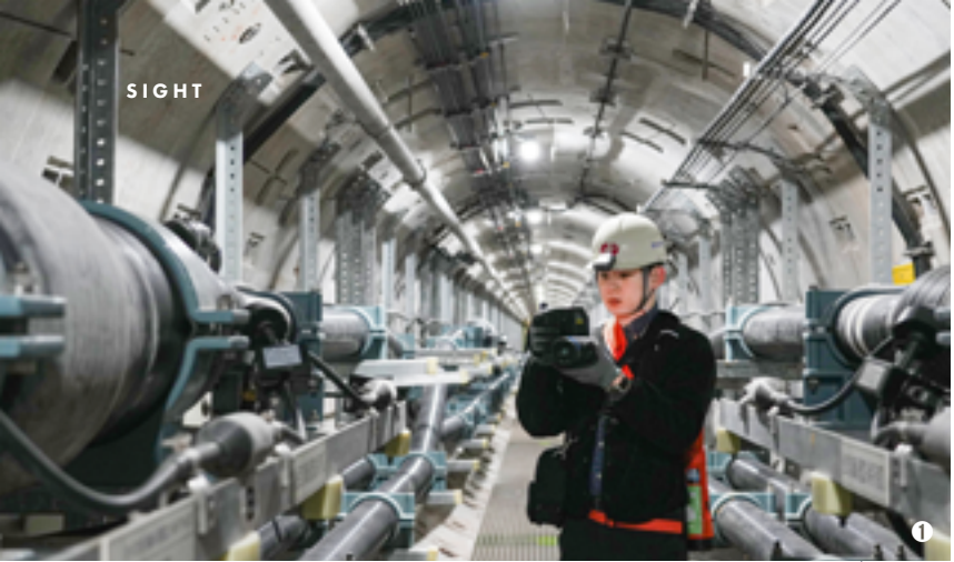
①, ③ 열화상 진단장비를 활용해 접속함 이상 유무를 면밀하게 살피는 순천전력지사 송전부 사수들. ②, ④ 해저터널 내 작업 시 안전을 위해 지상감시자와 PS-LTE 단말기로 통신하는 작업자.
