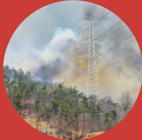
① 산불로 인한 연기가 '전선 간 전기가 흐르는 매개체' 역할을 하여 고장이 발생하며, 대부분의 산불영향 선로 정지가 이에 해당
